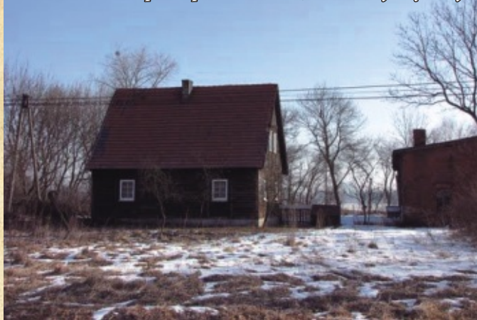
Drewniana chałupa z 1 poł. XIX wieku, konstrukcji zrębowej.
